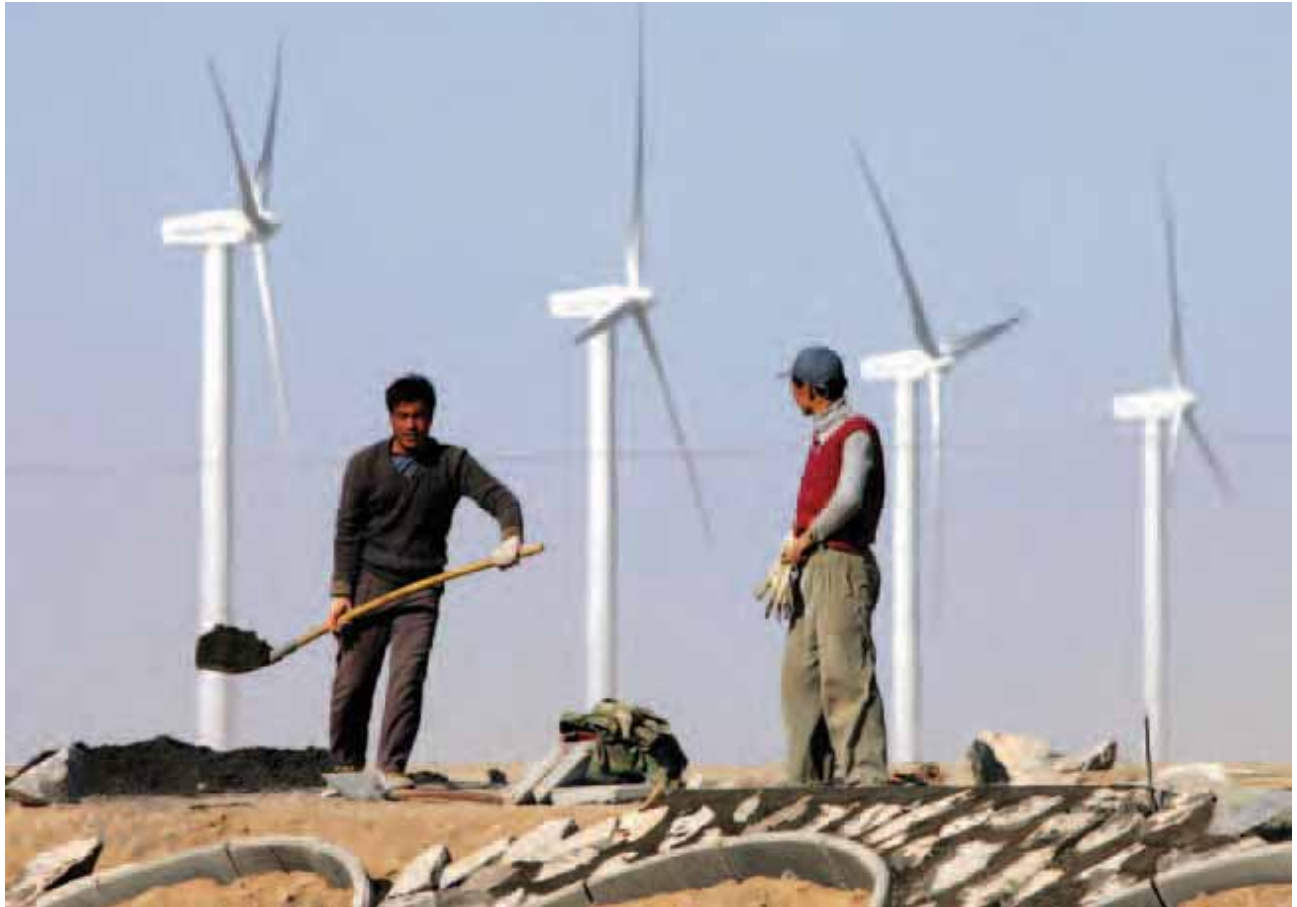
Éoliennes à Beijing (Chine)
